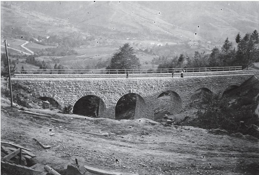
Épül a vasút Uzsoknál 1904-ben. (Fortepan_273919 Bachler család)
