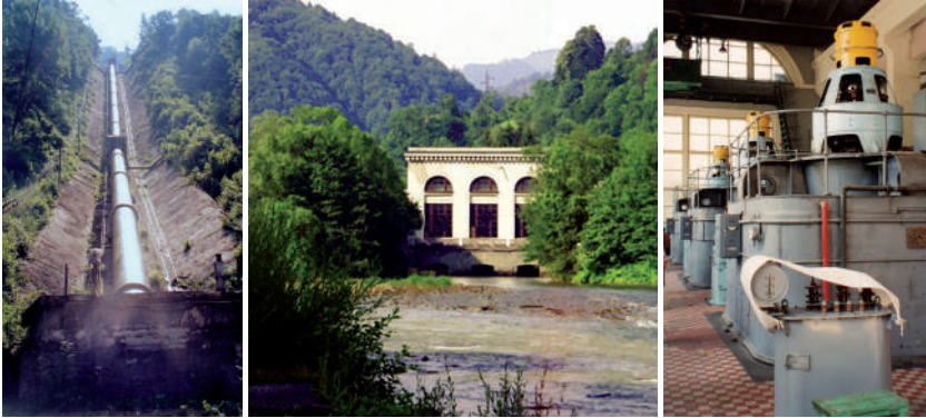
A víztárolóból az alagúton át a hegyoldalban megépített csövön érkezik a víz a Nagyházba. A turbinaház. A három turbina felső, áramfejlesztő része. (A szerző felvételei)
