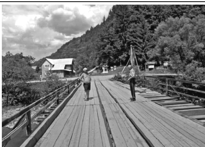
A közúti híd egyben vasútiként is szolgált
