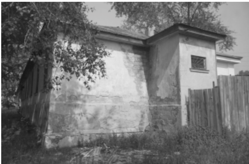
A fogolytiszték téglából épített háza
