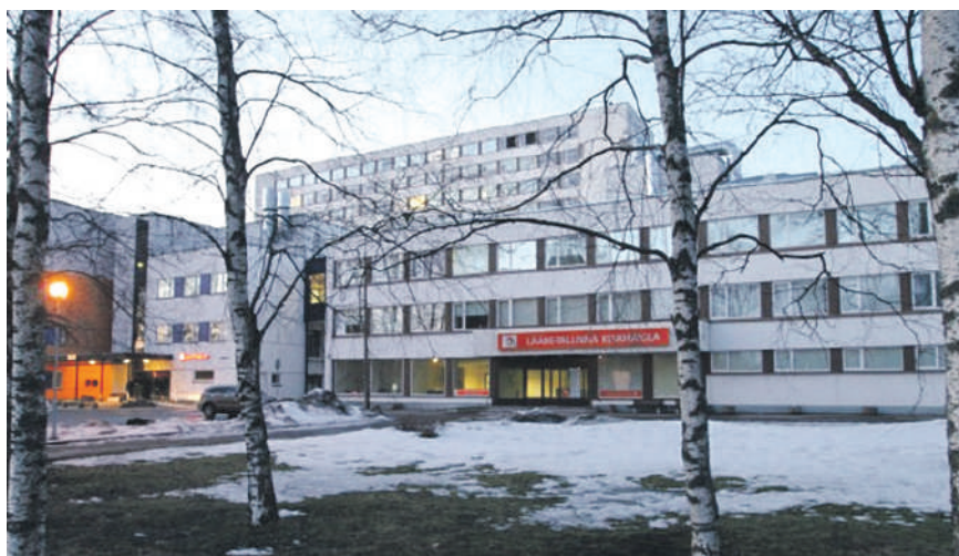
A Tallinni Central Hospital Emergency kórház komplexuma, amely az újjáépítés előtt, 1944–1948-ban hadikórházként is funkcionált Forrás: https://www.awbaltic.com/portfolio/west-tallinn-central-hospital/
