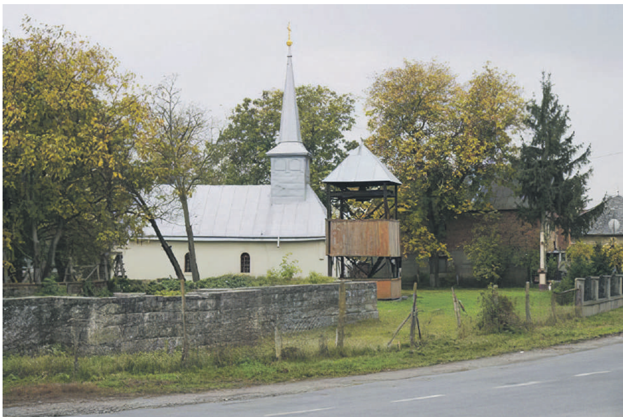
A tiszabökényi görögkatolikus templom felújítás előtt
